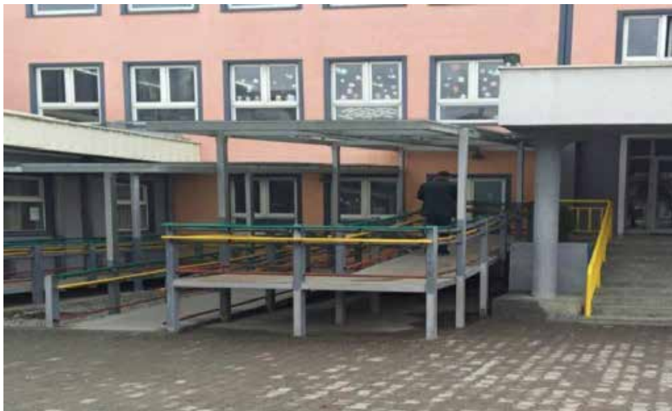
Fig 1. Pjerrina e modernizuar nga projekti i realizuar në shkollën fillore “Thimi Mitko” në Gjilan
